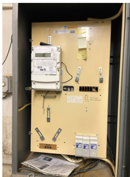
elektroměr-nepřímé měření na straně VN
